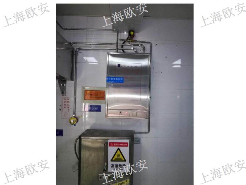
厨房设备灭火装置操作说明1、自动控制：整个灭火装置设计为自动灭火系统，厨房灶台油锅燃烧后，火焰发出的巨大热量使感温器动作，传递探测信号给控制盘，输出启动信号，启动灭火装置，实施灭火并喷水冷却，同时可以通过控制盘切断燃气电磁阀、关闭排烟风机。2、启动延时功能的作用是确保设备喷放时机的准确性，出厂默认设置是15s延时喷放。3、取消启动命令：当未发生火灾且装置发出启动命令并发出报警声进入待启动状态时，为了避免不必要的损失可人为关闭控制盘电源开关停止即将发生的勿喷。（打开控制盘箱体门，同时关闭主电和备电电源开关即可停止）通知专业人员进行设备检修后再投入使用。4、手动控制：当厨房灶台油锅燃烧时，如果系统未能按照预期“自动”启动灭火系统，也可以通过“手动”启动，按下紧急启动按钮，系统就会按照“自动”灭火流程实施灭火。江苏厨房灭火装置配件厨房自动灭火系统全国销售。
